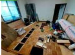
屋根工事に引き続いて、内部の水廻り改修工事が始まりました。新しくキッチンとなる部屋の痛んでしまった床を補修しています。今回は水廻りの改修に合わせて、オール電化にするためエコキュートを設置しています。エコキュートは貯湯タンクにお湯を貯めておくという特徴があり、断水時に生活用水としても活用できるため、防災を意識した改修におすすめです。
