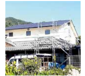
北春日町屋根改修工事 (西京区大原野)
