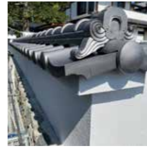
お寺土塀工事 (北区西賀茂)
